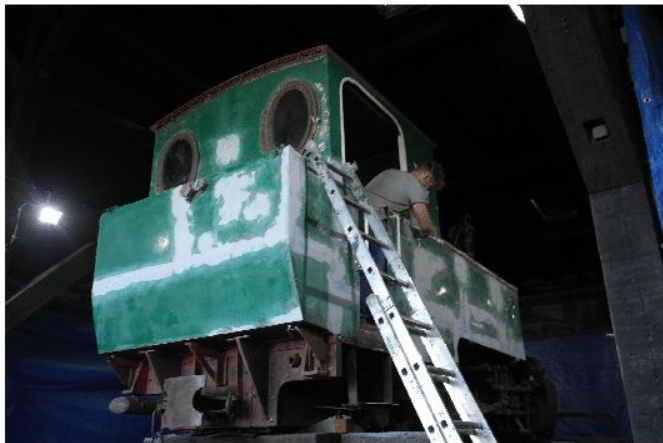
Renowacja poszycia lokomotywy
