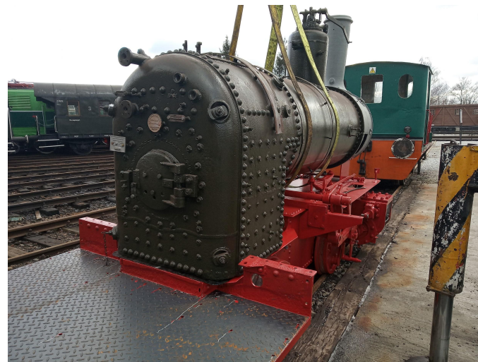
Kocioł lokomotywy T49 po zakończeniu prac
