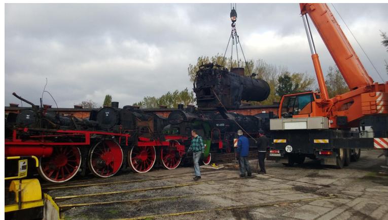
Demontaż kotła parowozowego z TKt48-18
