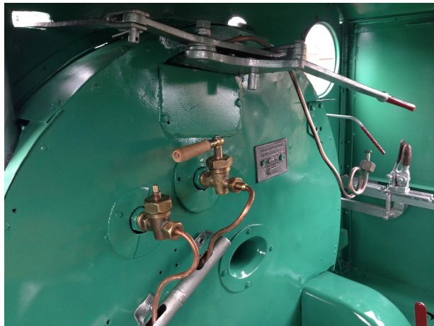
Wnętrze kabiny po zakończeniu prac
