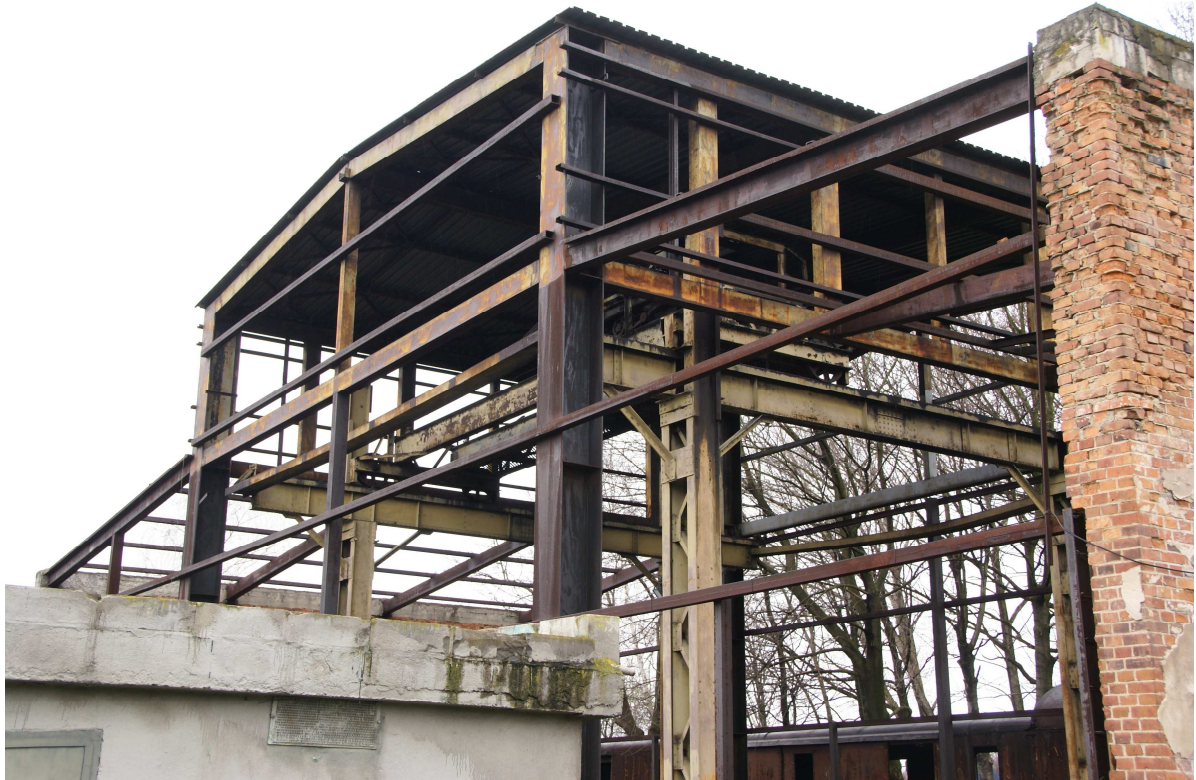
Ogólny widok kompleksu suwnicy i zapadni podtorowej.
